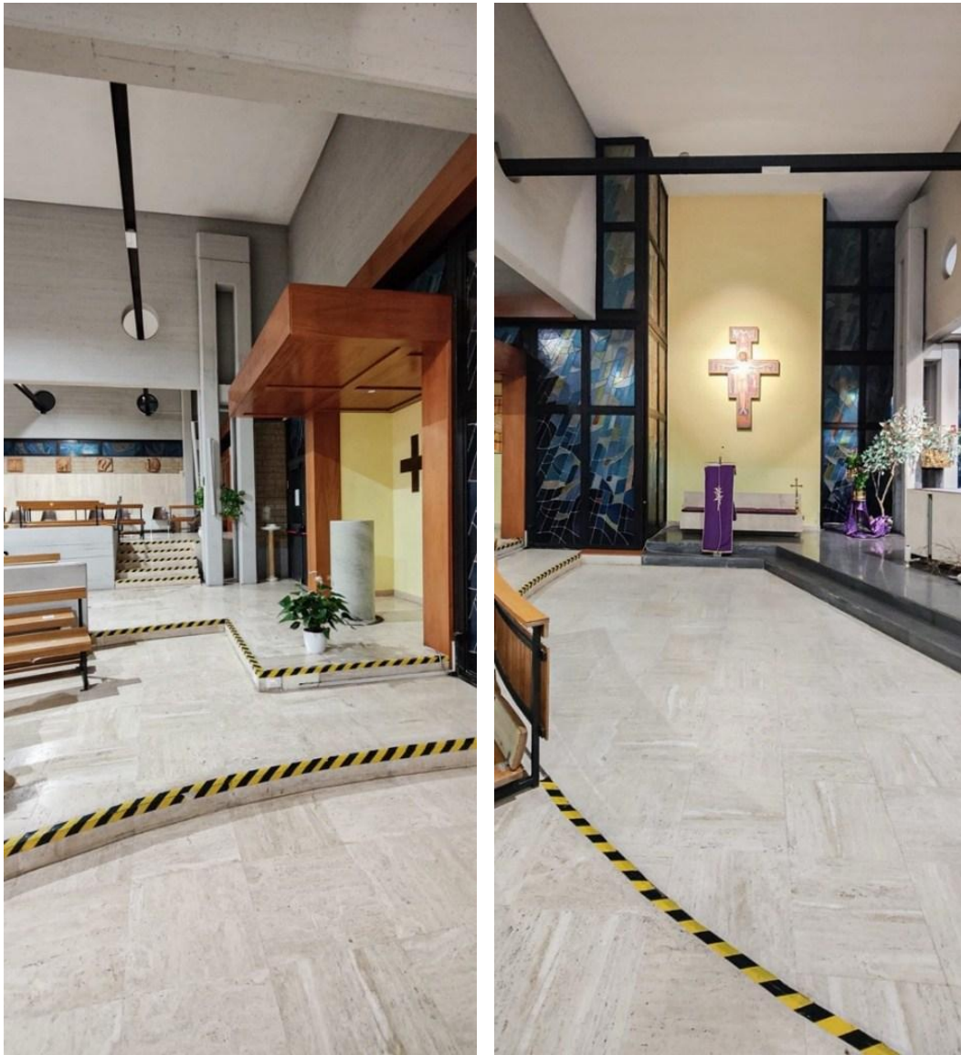
Fig. 12 : Avant travaux, vue du baptistère de l'église Saint-Vigile, Rome (Italie).
